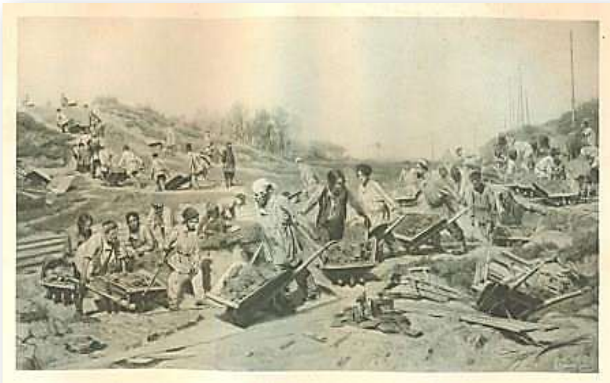
К. А. Савицкий. Ремонтные работы
